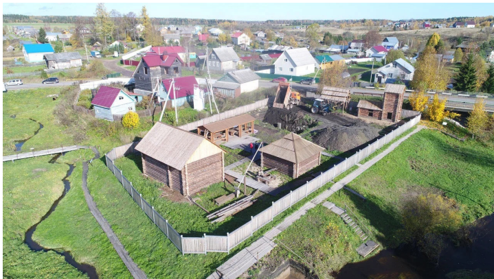
22. Идёт реконструкция солеваренного завода в окрестностях Тотьмы.
